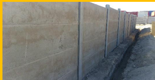
Cierros de Hormigón
